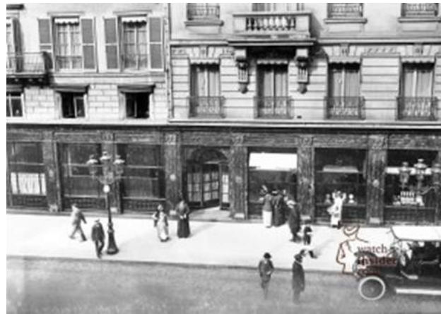
Resim 6: Rue Montorgueil'de Cartier Evi, Paris, 1847
