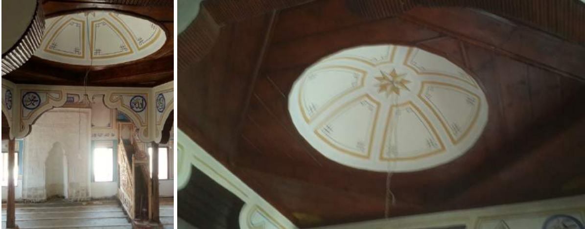
Şekil 6. Camide kubbeli döner eksenli bindirme tavandan görünüm (Kaynak: Yazarlara ait fotoğraf arşivi, 2016).
