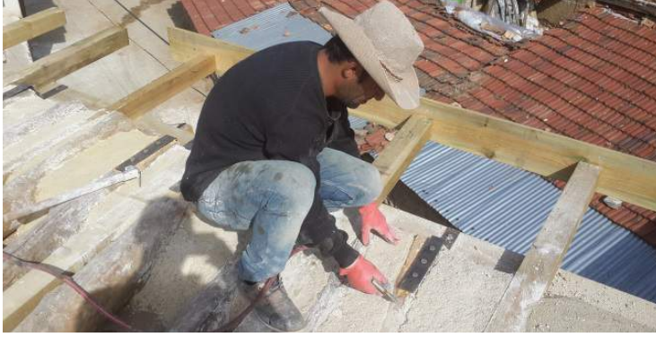
Şekil 14. Çatıda saçakların yenilenmesi ve hatıllarda çelik profiller ve bulonlar ile birleşim detayını gösterir fotoğraf (Kaynak: Yazarlara ait fotoğraf arşivi, 2016).
