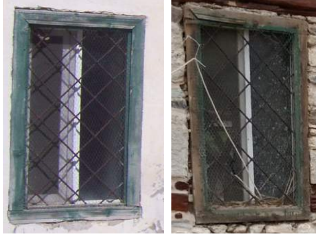
Şekil 3. Pencere metal geçmeli parmaklarının fotoğrafları (Kaynak: Vakıflar Genel Müdürlüğü Arşivi, 2013; Yazarlara ait fotoğraf arşivi, 2016).
