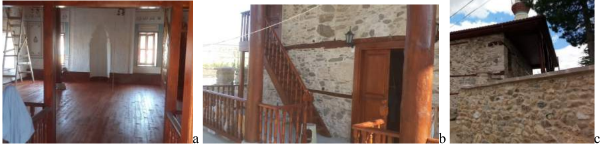
Şekil 17. Yenilenen ahşap (a-b) ve taş (c) elemanlardan görünüm (Kaynak: Yazarlara ait fotoğraf arşivi, 2016).
