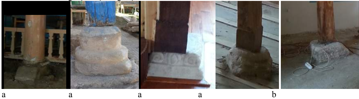
Şekil 1. Harim iç mekanda (a) ve son cemaatte (b) araştırma kazıları sonucu döşeme altından çıkan taş ayaklar (Kaynak: Yazarlara ait fotoğraf arşivi, 2016).
