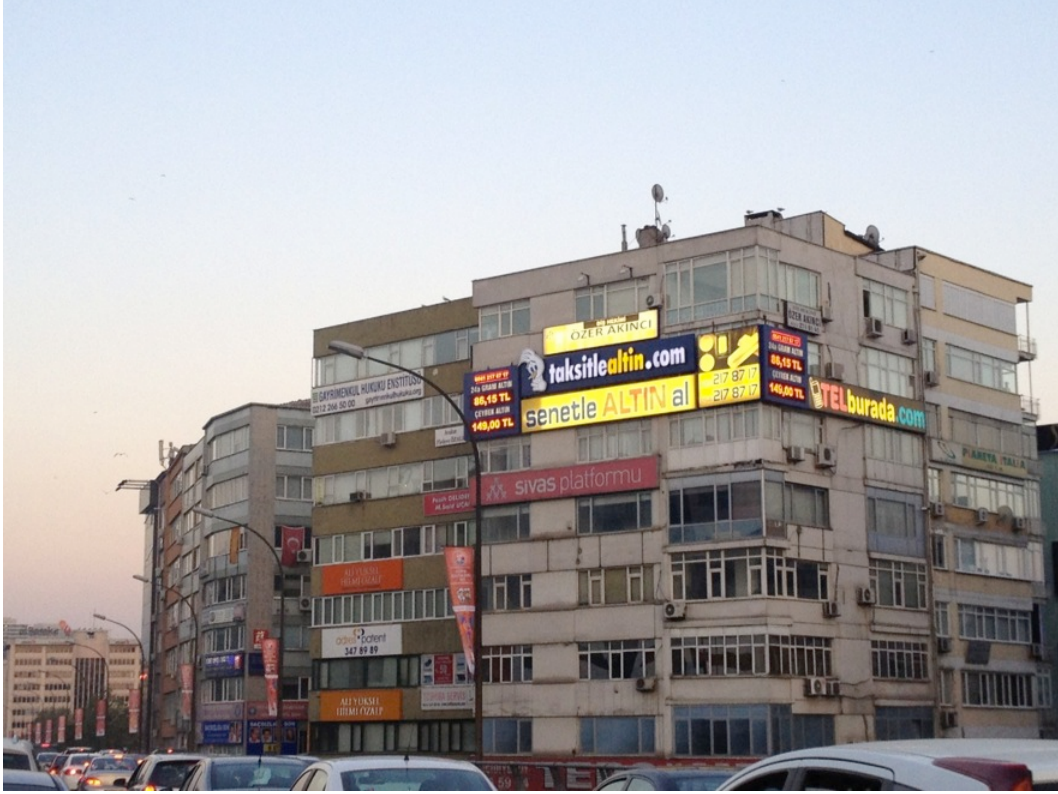
Resim 8. Bina dış cephesinde yer alan “yama” gibi duran dijital led tabela örnekleri.
